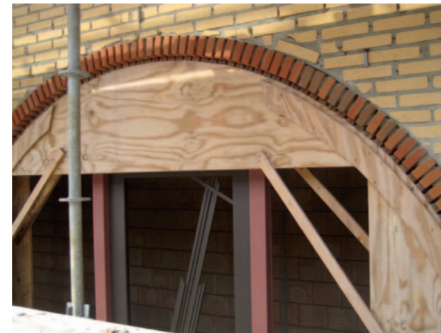
Een formeel is de, veelal houten, ondersteuningsconstructie bij het metselen van een boog of gewelf die voor de gewenste vorm zorgt.
