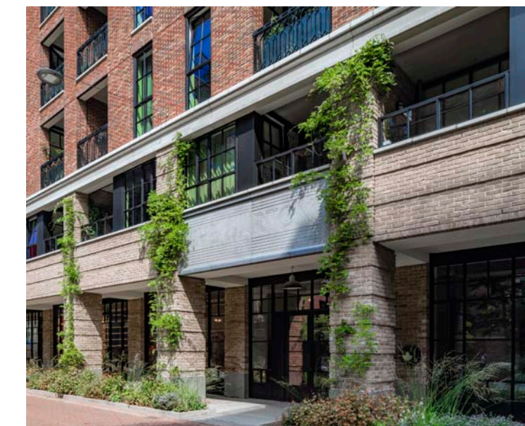
Loopbruggen zorgen voor de ontsluiting. Er was geen ruimte om in elk gebouw een trap en lift te maken (linksbeneden).
